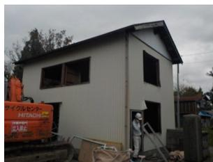
機械足場には、現地より発生したタタミを敷いて一応の養生としながら作業します。残す土間コン部分にはカッターを入れて綺麗に撤去できるようにします。
