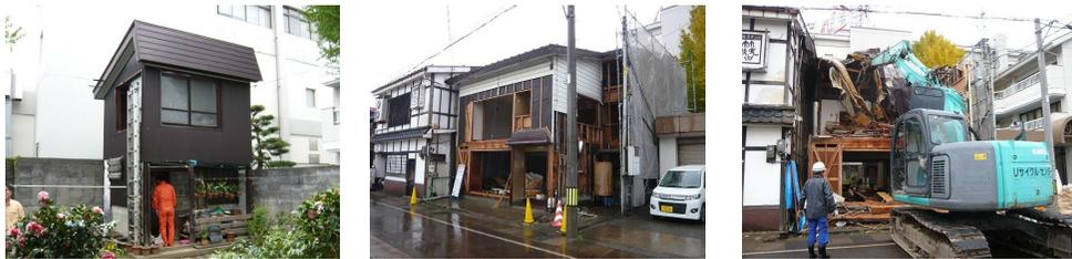
住宅の他に物置が1棟あります。機械を前から入れ、少しずつ奥へと解体作業を進めます。解体後は、隣家の外壁を復旧して完了です。
