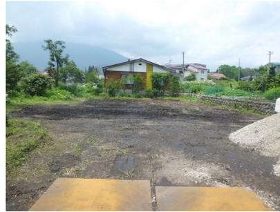
通常の木造住宅ですが、通路が舗装されていない為、鉄板にて通路を養生します。結構な距離があるため、敷鉄板設置費用も工事代金に含まれます。
