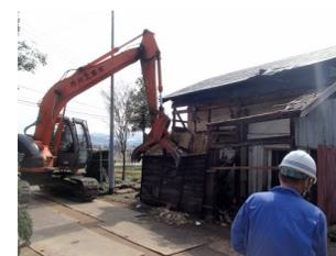
最初に雨屋部分を取り壊してから、土蔵を解体します。解体した柱材の一部をこれから出来る新築住宅の薪ストーブ用の燃料として利用するとの事です。
