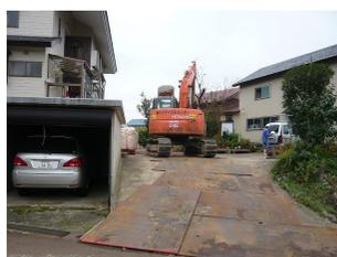
土壁のホコリ防止のため、散水しながら解体して行きます。土と木くずを分別しながらの作業が手間と時間がかかります。要らない土を撤去して整地します。
