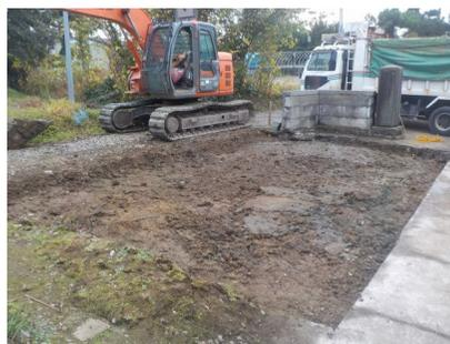
通常の倉庫で、残す納屋部分との切り離し作業があります。作業用通路が狭く、また長いので、通路養生用の鉄板の枚数が多くなります。
